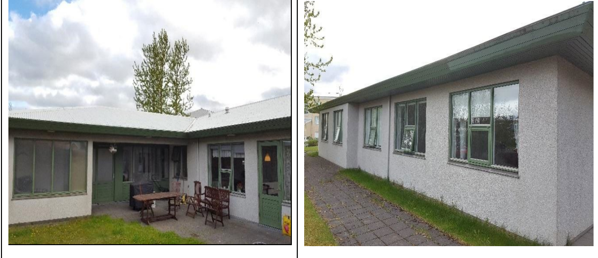
Mynd. Endurmála þarf þakjárn og tréverk utanhúss.
