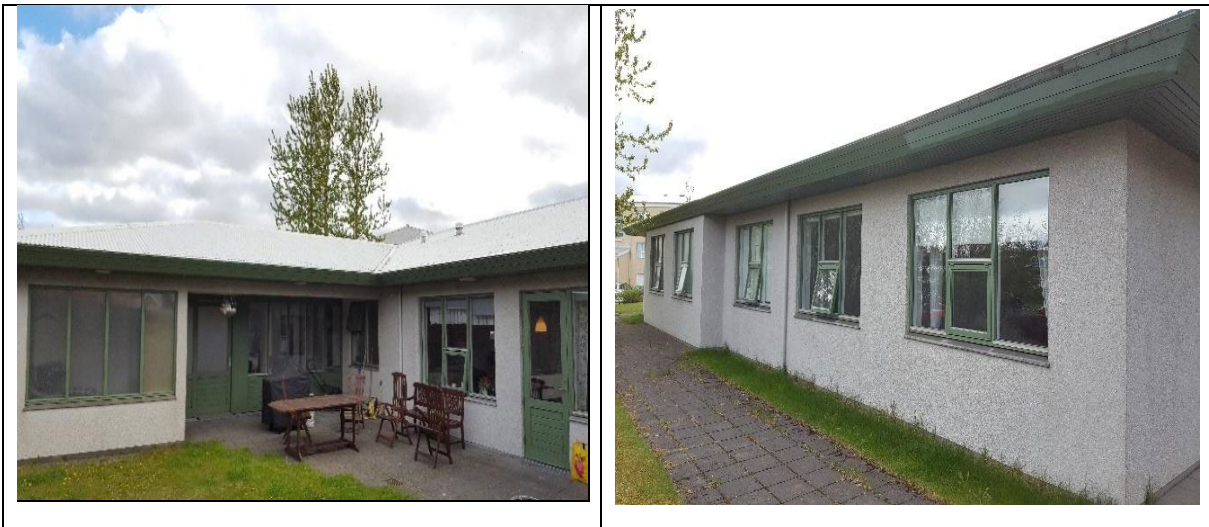
Mynd. Endurmála þarf þakjárn og tréverk utanhúss.
